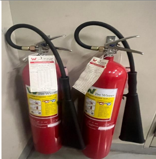
ภาพที่ 26 เครื่องดับเพลิงแบบมือถือ
