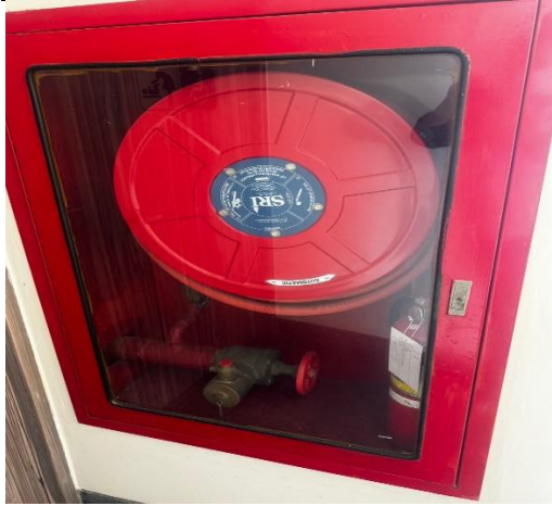
ภาพที่ 23 ตู้สายฉีดน้ำดับเพลิง
